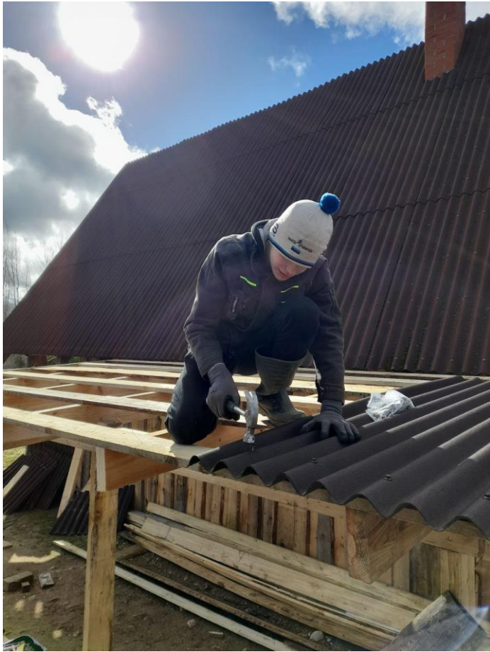
Joonis 8. Katuseplaadi paigaldamine. (A..Linderi erakogu)
