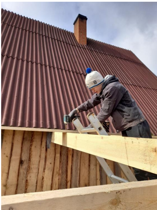
Joonis 7. Roovide paigaldamine. (A.Linderi erakogu)
