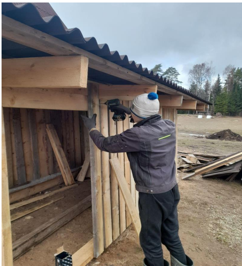
Joonis 4. Seinte ehitamine servatud laudisega. (A..Linderi erakogu)
