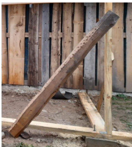
Joonis 2. Otsapostide kinnitused, diagonaalid. (A.Linderi erakogu)
