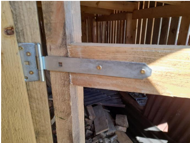
Joonis 9. Uksehing. (A..Linderi erakogu)
