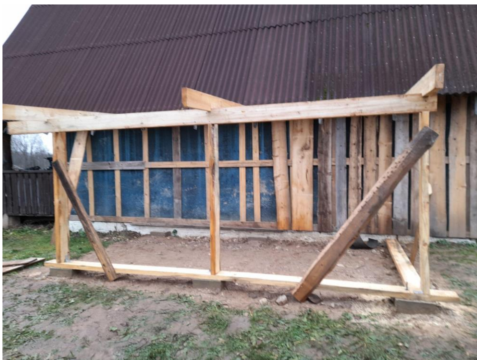
Joonis 3. Ülemise vöö paigaldamine nurgapostide peale.(A.Linderi erakogu)
