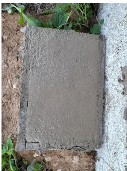
Joonis 1. Saalungi valamine betooniga. (A.Linderi erakogu)
