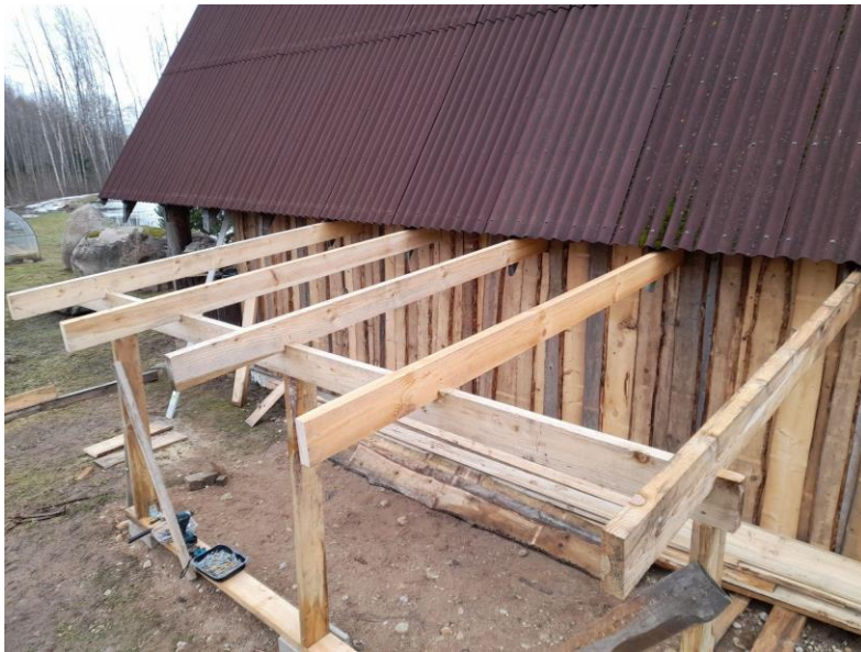
Joonis 6. Sarikate kinnitamine ülemise vöö külge. (A..Linderi erakogu)
